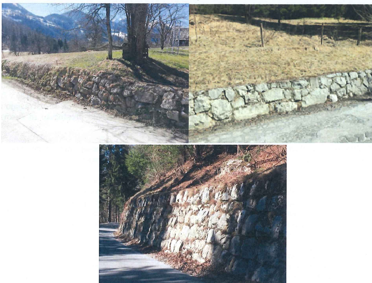
Slika: tradicionalni oporni zidovi (uporaba lokalnega klesanega kamna, poglobljene fuge, vodoravni pasovi zlaganja, vrh zidu je prekrit z ozelenjeno zemljino, zid v rahlem naklonu, vrh sledi naravni oblikovanosti terena)
